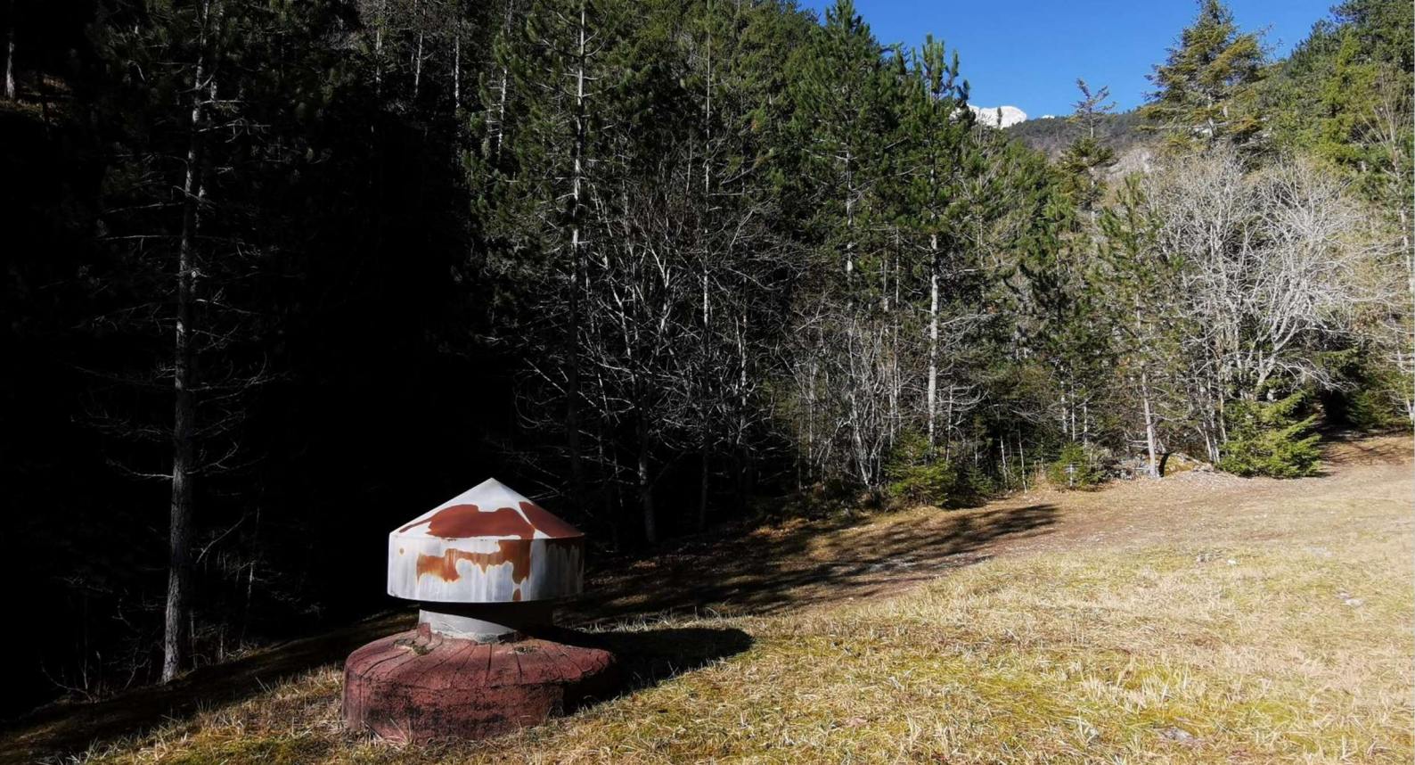
5 Bouche d'aération de la station d'épuration
