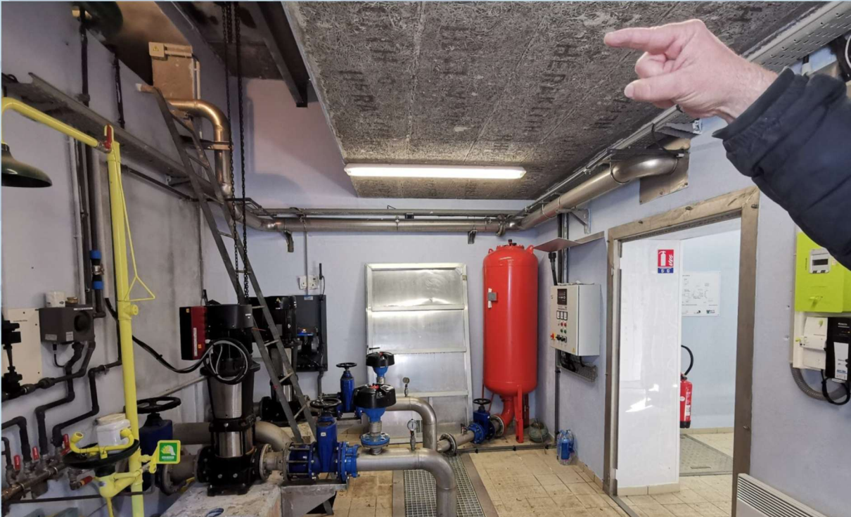
12 Zone de nettoyage du personnel
